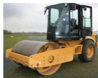
Miután több sor lefektetésre került, azokat be kell hengerelni, az utolsó sort pedig hengerelés nélkül kell hagyni, hogy készen álljon a következő szekciók csatlakoztatására.
