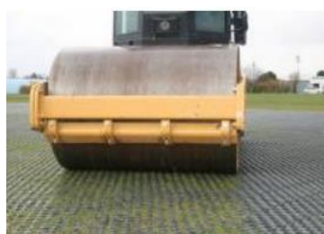
Kis szögben hengereljünk, hogy elkerüljük a lapok közötti illesztések mentén való közvetlen áthaladást.
